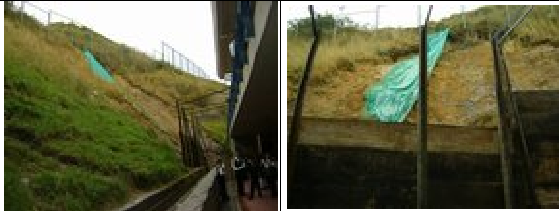
DESLIZAMIENTO DE TALUD
